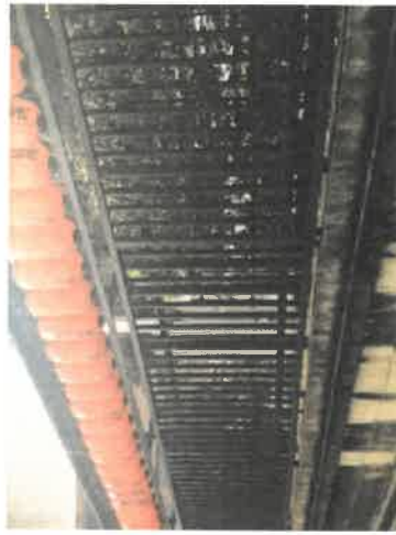
▲設置箇所の鉄枠
