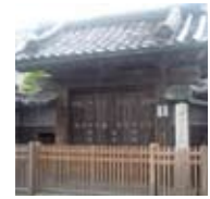
清洲信本陣跡 江戸時代、美濃路最大の本陣。地震や火災に遭い、現在は正門のみが残る。
